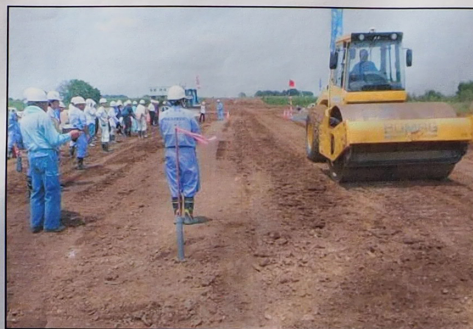
締め固め管理の説明状況
