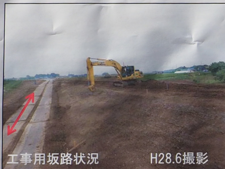
工事用坂路施工状況 H28.6撮影
