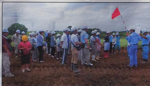
盛土の施工状況説明
