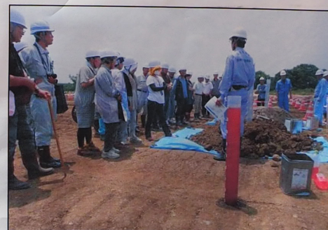
現場透水試験の説明状況
